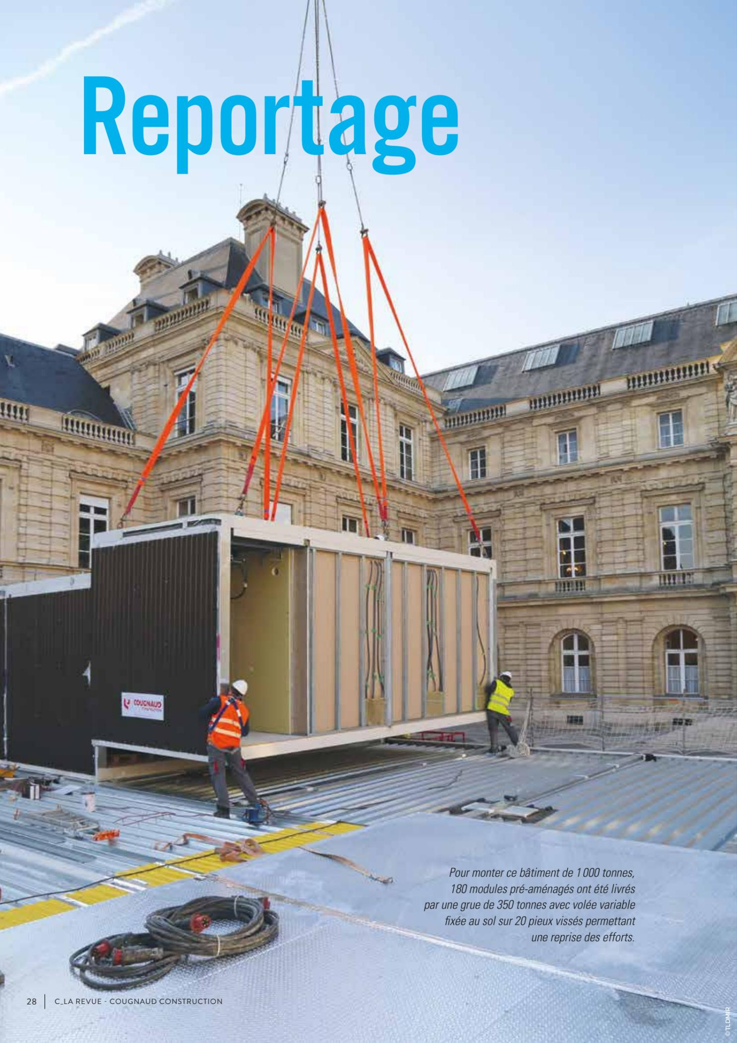
*Pour monter ce bâtiment de 1 000 tonnes, 180 modules pré-aménagés ont été livrés par une grue de 350 tonnes avec volée variable fixée au sol sur 20 pieux vissés permettant une reprise des efforts.*
